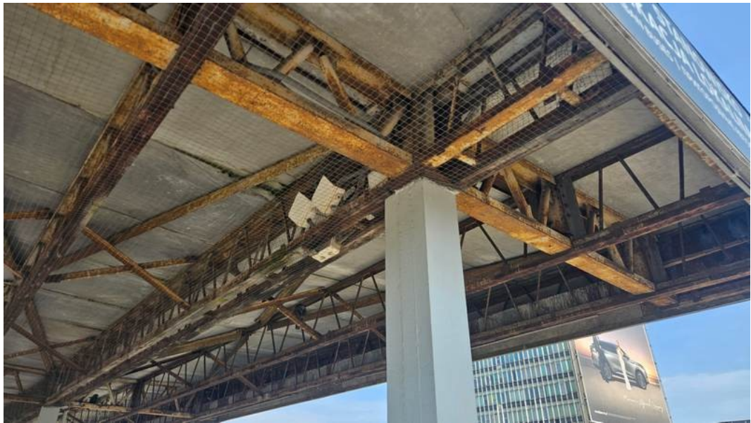
Fot. 6 Konstrukcja Wiaty 0
